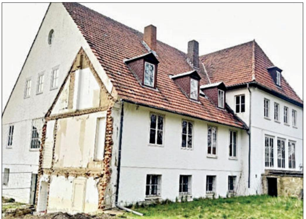
**Der Gebäudeteil im Süden (Foto oben) wurde nach der Zerstörung im Januar 1944 als erster wieder aufgebaut. Die Substanz ist zu schlecht; er muss abgerissen werden. Schreck bei den Abrissarbeiten: Das Fundament des Gutshauses ist stark unterspült (Foto Mitte). An der Stelle des abgerissenen Gebäudes (Foto unten) entsteht später der Anbau mit Aufzug und Treppenhaus.**
