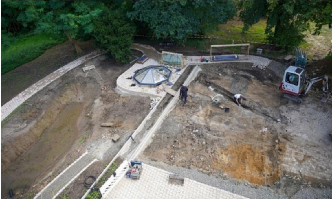
Der Außenbereich ist noch nicht ganz fertig. Foto: Matthias Kettling
